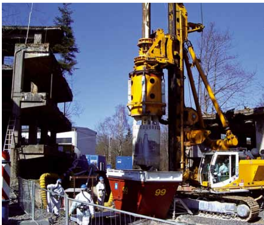
Sanierung der Rüstungsaltlast Hessisch-Lichtenau
