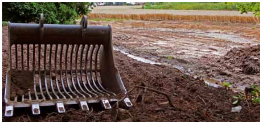
Renaturierungsmaßnahme am Mosbach in Wiesbaden
