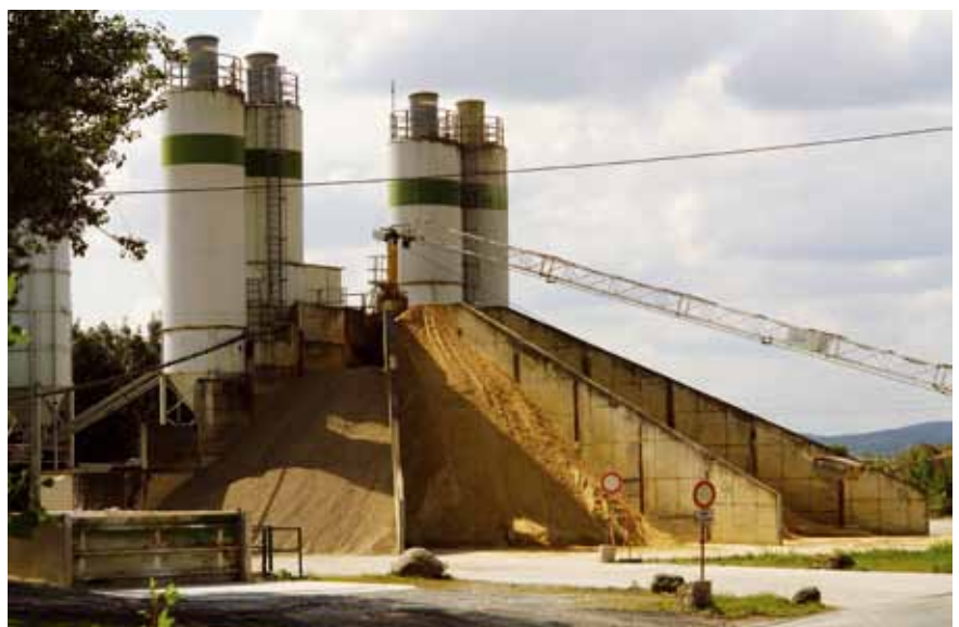
Die wichtigsten oberflächennahen Bodenschätze in Hessen sind u. a. Hartgesteine, Sande und Kiese.
