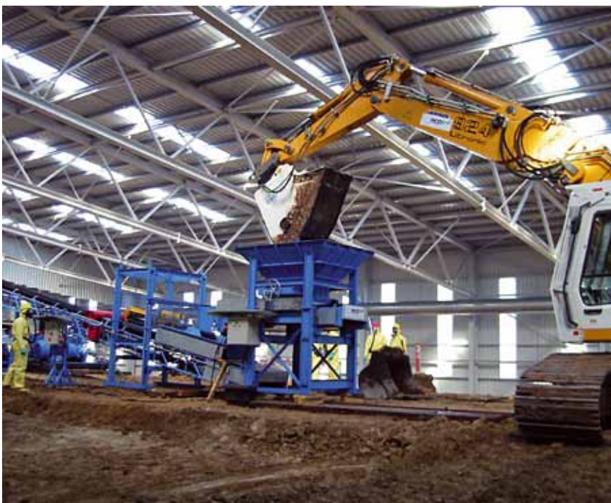
Sanierung der TRI-Halde in Stadtallendorf
