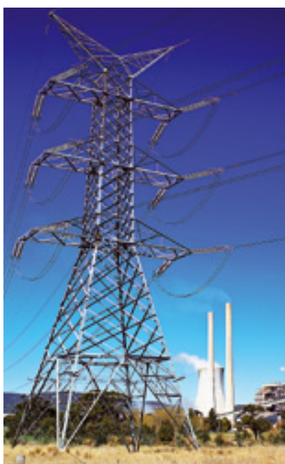
Strommast und Kraftwerk (Quelle: HMUELV)
