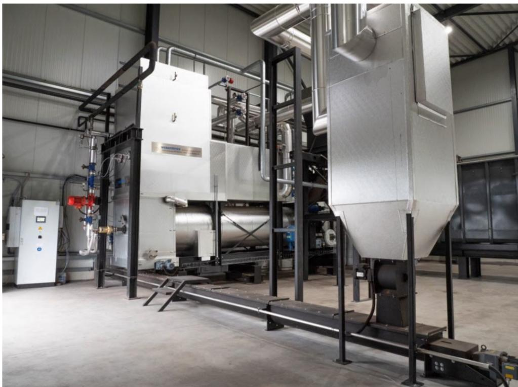
Abb. 9-9: Drehrohrföfen mit Abgasreinigung, Referenzanlage, Foto: Anbieter
