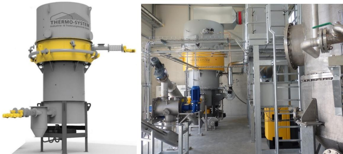
Abb. 6-15: KlärschlammReformer, Fa. Thermo-System auf der Kläranlage Renningen (Thermo-System, 2020)
