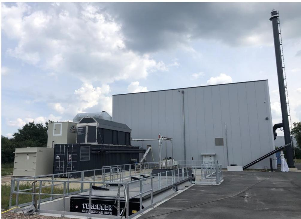
Abb. 9-7: Annahmehunker (vorne), Paddeltrockner (Container hinten links) Ablufttechnik (hellgrau) sowie Stahlhalle für Verbrennungstechnik, Referenzanlage 6.000 t/a, 25 % TM, Foto: Anbieter
