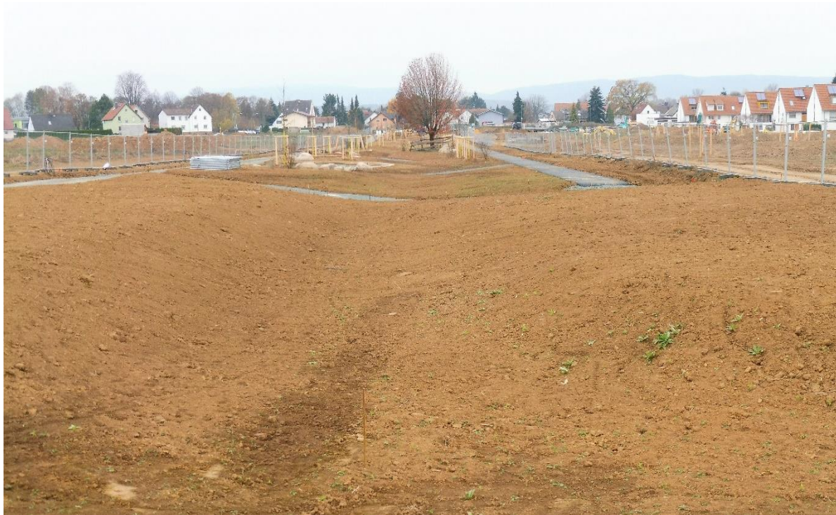
Foto 2: Schutz späterer Freiflächen durch Abzäunen in der Erschließungsphase
