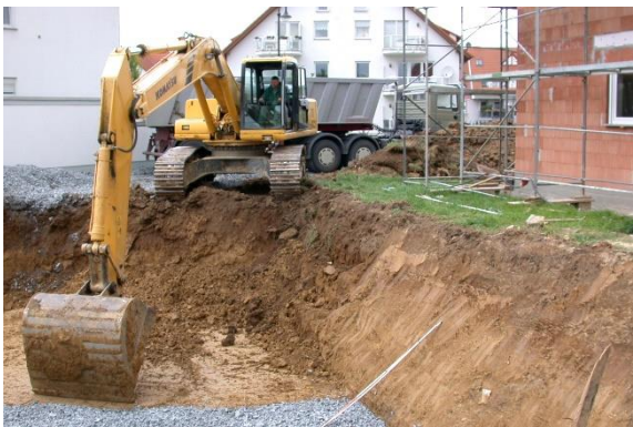
Bodenarbeiten in einem Neubaugebiet
