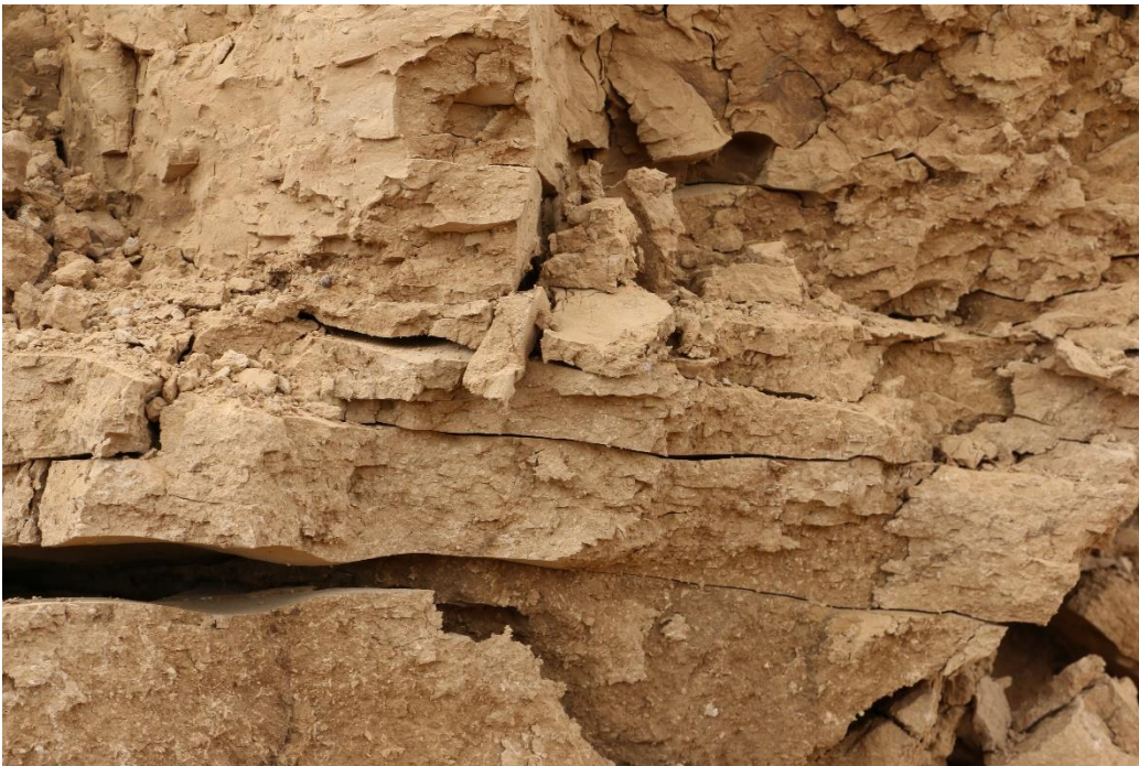
Foto 4: Stark verdichteter Boden im Bereich einer Straßenbaustelle
