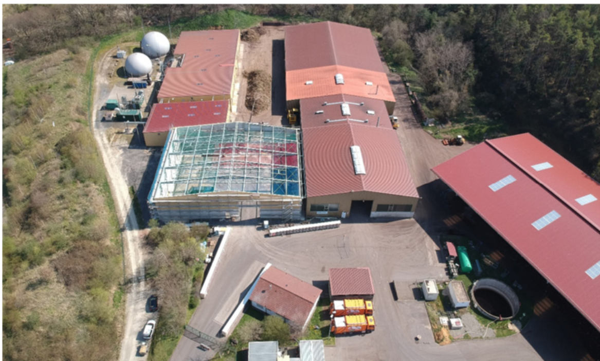
Biokompostierungs- und Vergärungsanlage in Lohfelden
