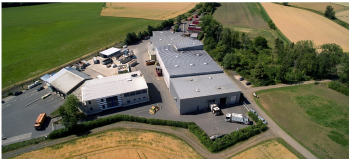
Mechanische Abfall-Aufbereitungsanlage in Echzell
