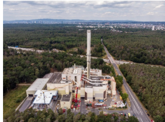
MHKW Offenbach mit Monoklärschlammverbrennung
