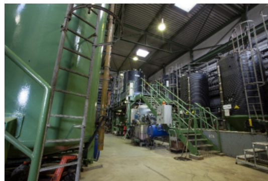
Halle der chemisch-physikalischen Behandlungsanlage HIM Kassel
