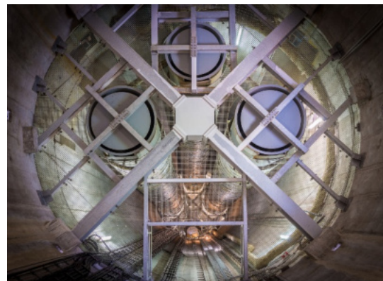
Innenaufnahme des Kamins des MHKW Darmstadt
