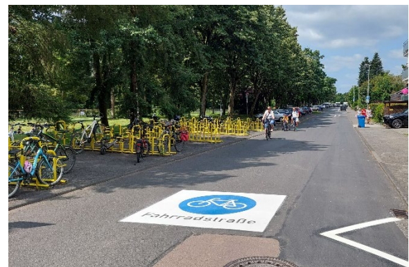
Abb. 70: Umsetzung der Fahrradstraße Schleusenweg; Quelle: Stadt Limburg
