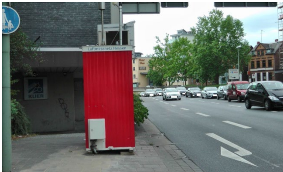
Abb. 4: Verkehrsbezogene Luftmessstation Limburg-Schiede; Foto: HLNUG
