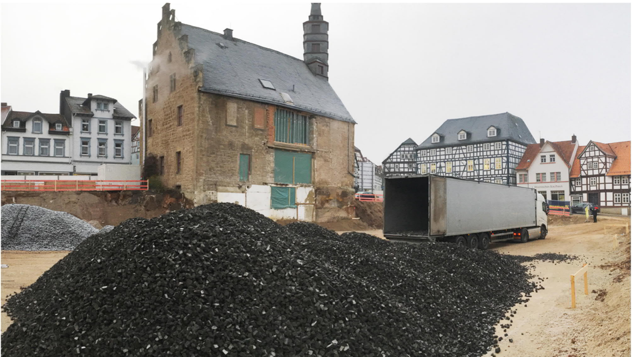
Abb. 51: Einbringung des Schaumglasschotters auf dem Plenum zur Dämmung der Bodenplatte
