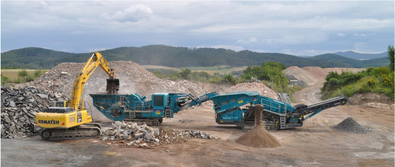
Abb. 37: mobile Recyclinganlage bei Fa. Funke in Volkmarshen
