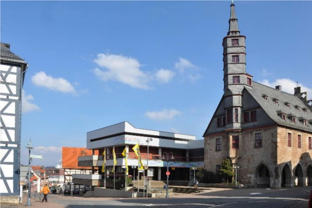
Abb. 4: Historisches Rathaus (rechts) und Anbau von 1970 (links)
