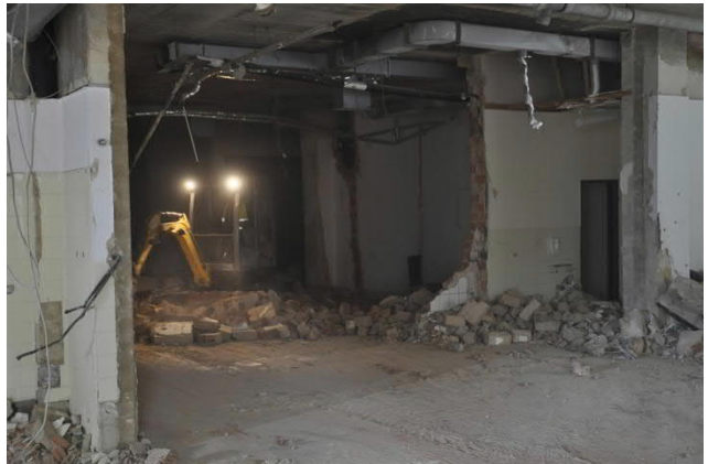
Abb. 33: Ausbau Ziegelmauerwerk
