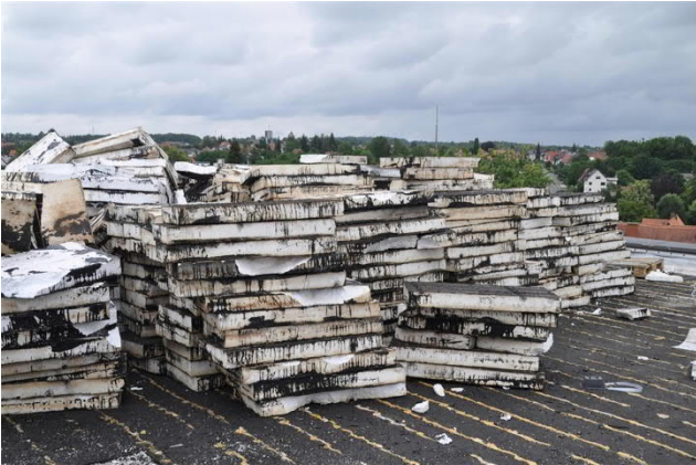
Abb. 32: EPS-Dämmstoffe auf dem Flachdach
