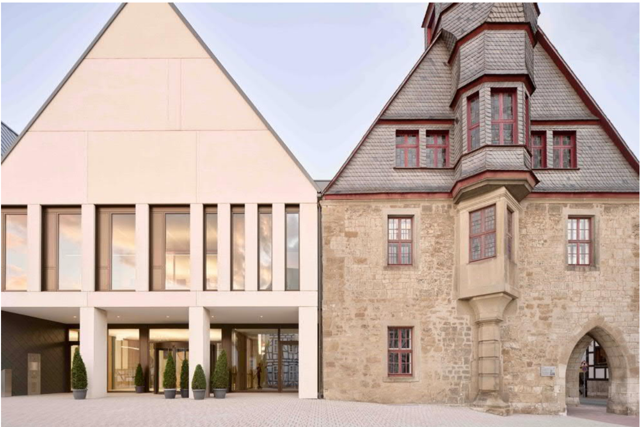
Abb. 79: Fassaden von Neubau (links) und historischem Rathaus (rechts), Foto: Caspar Sessler
