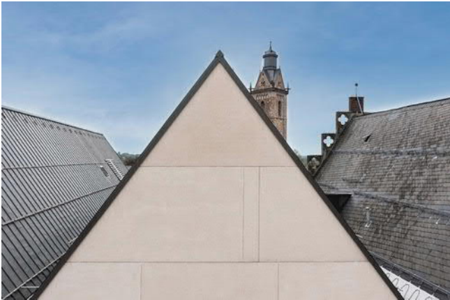
Abb. 84: Dach mit Zink-Stehfalzdeckung, Foto: Ali Moshiri
