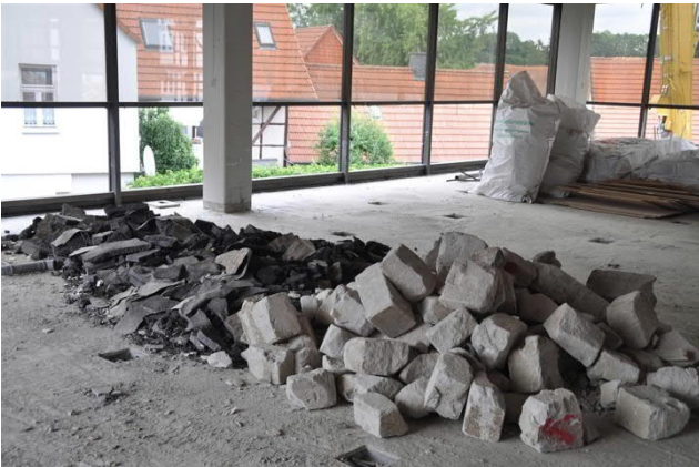
Abb. 34: Gussasphaltestrich und Porenbeton
