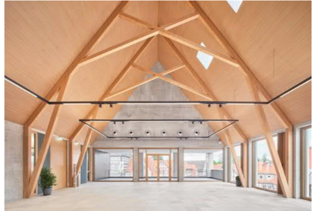
Abb. 85: Ratssaal mit Dachtragwerk aus Baubuche, Foto: Caspar Sessler
