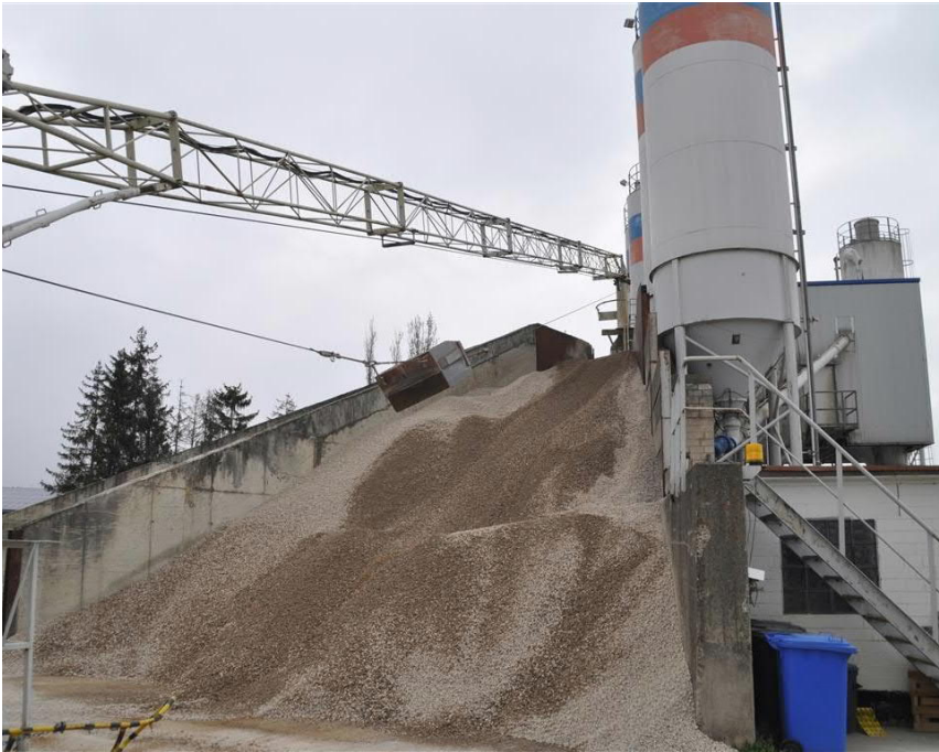
Abb. 41: Herstellung des R-Betons im Frischbetonwerk Korbach
