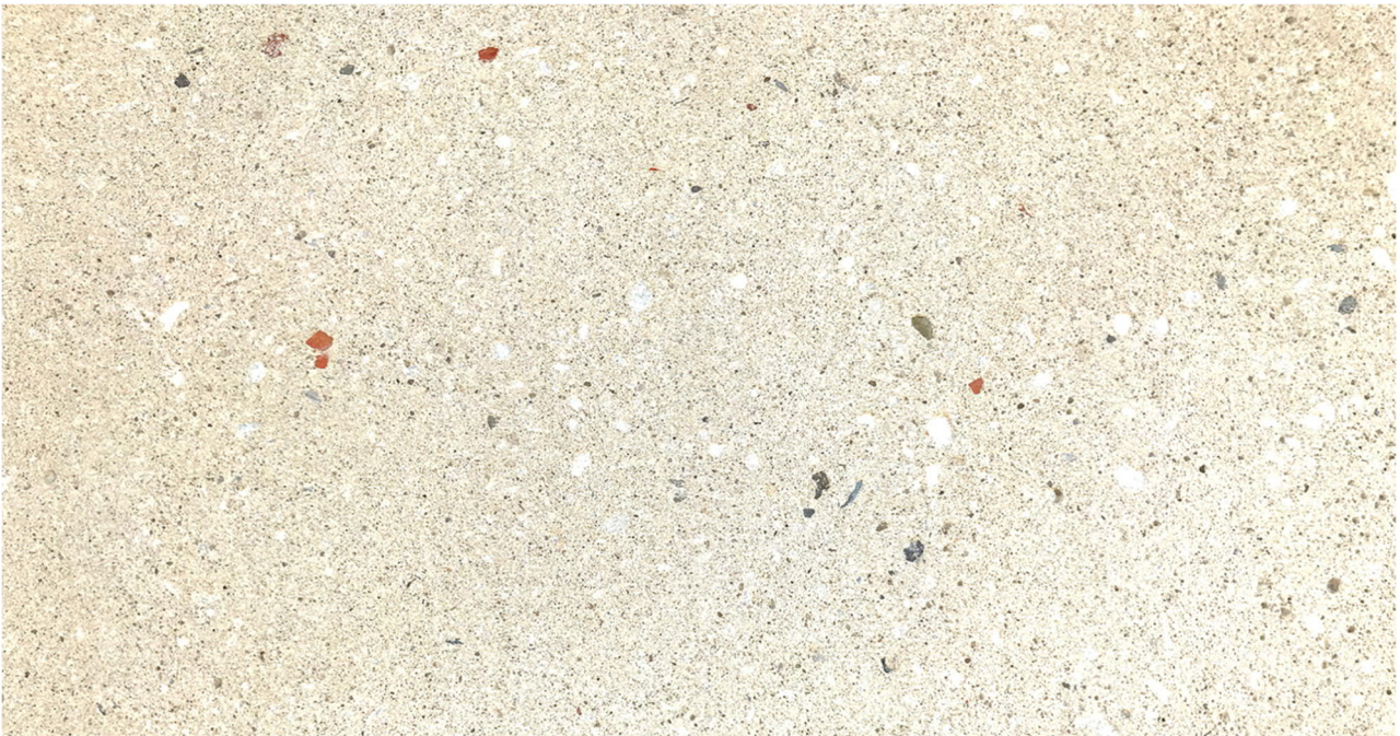
Abb. 17: Sichtbetonfassade mit Ziegelrezyklat, Oberfläche sandgestrahlt
