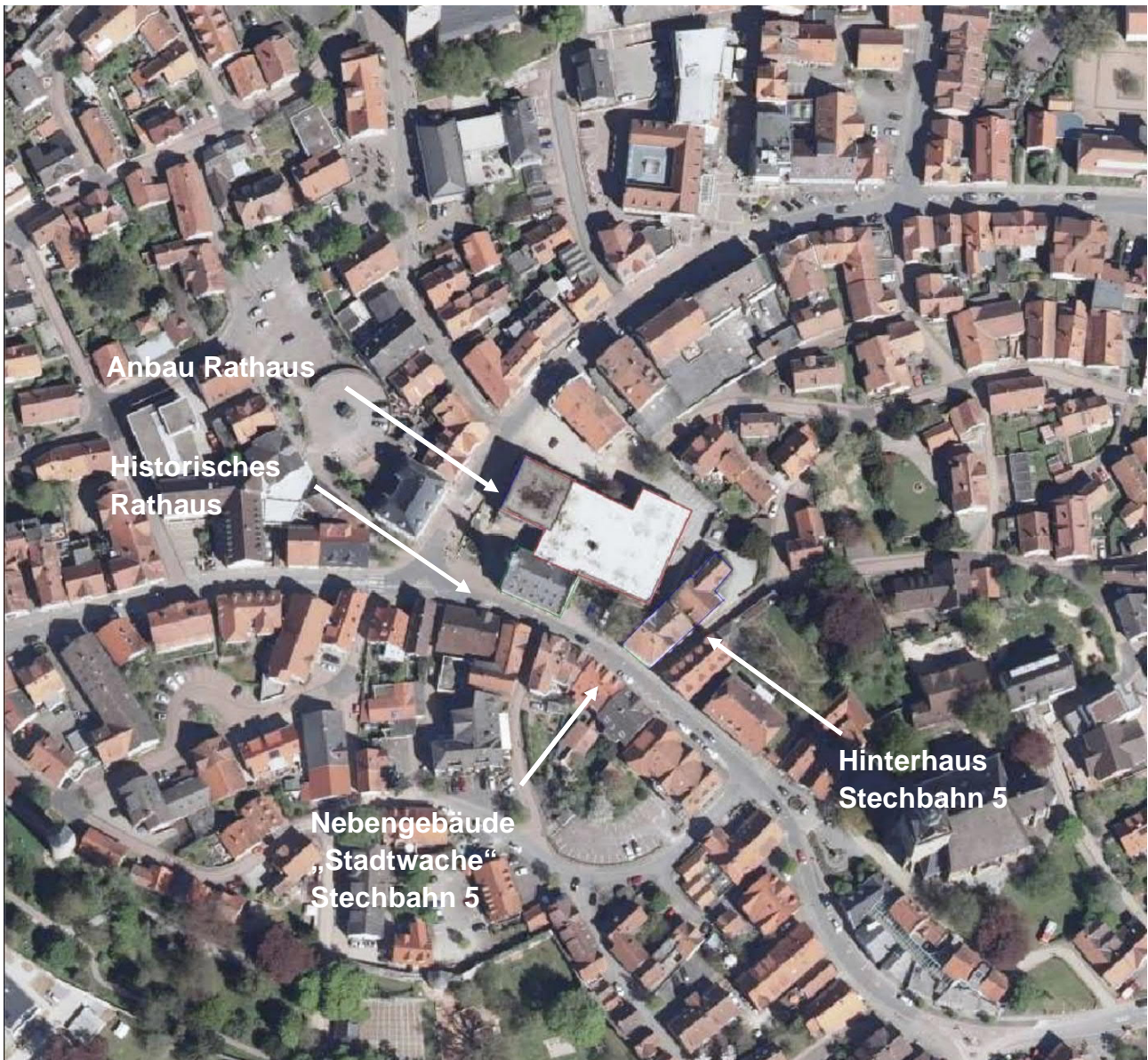
Abb. 5: Luftbild mit Lage der Bestandsgebäude vor dem Rückbau (Quelle: Geoportal Hessen; 09.07.2018)
