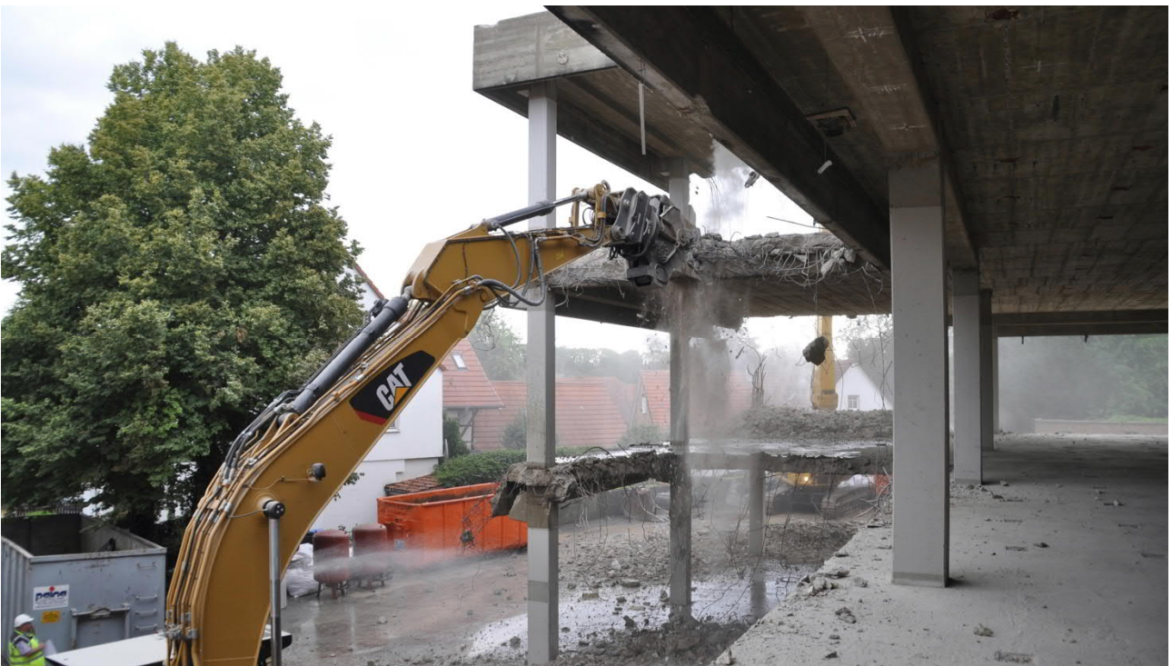
Abb. 35: Abbruch des Stahlbeton-Tragwerks
