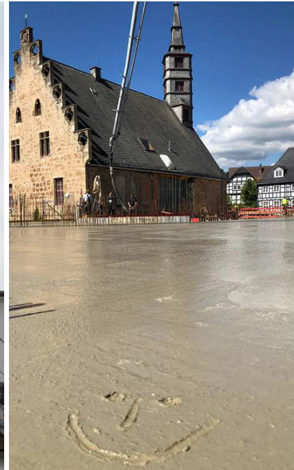
Abb. 42: Einbau des R-Betons für die Sockelgeschossdecke, Foto: Antje Paul
