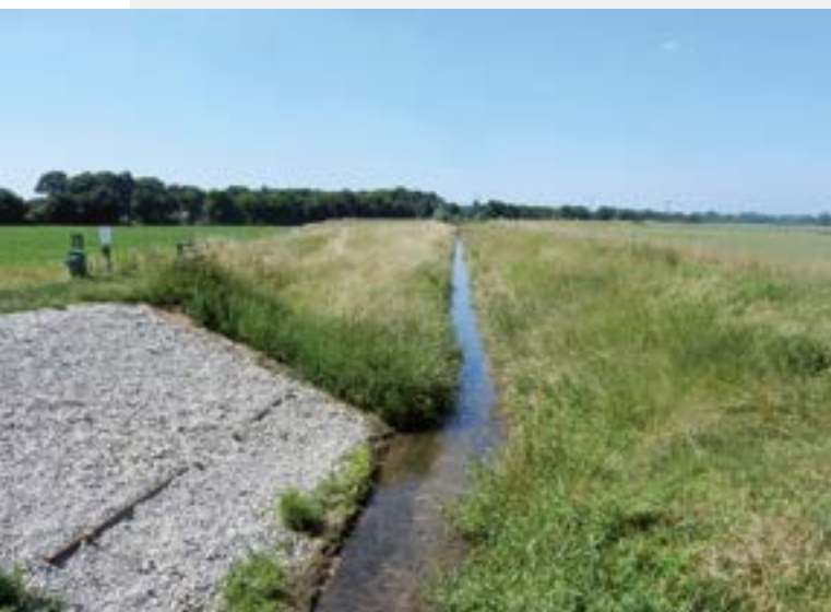
▲ vor der Maßnahme
