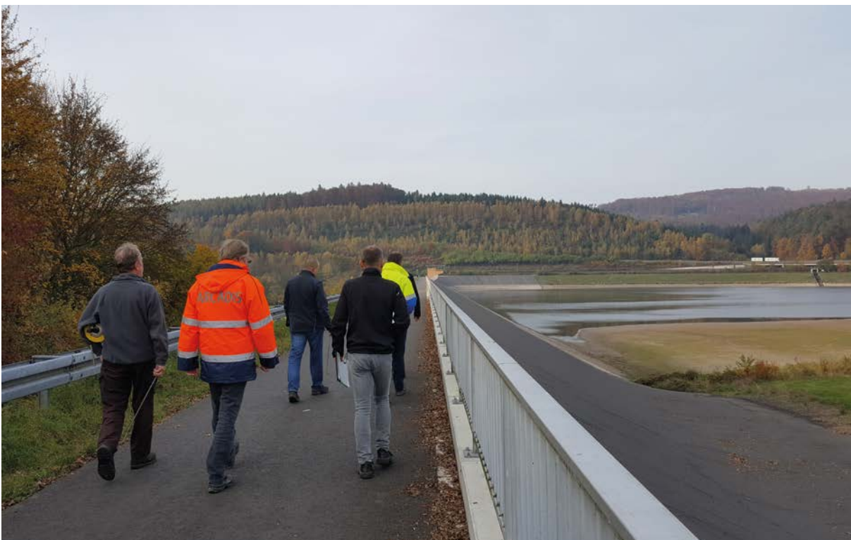
Abbildung 25: Begehung im Rahmen einer Sicherheitsüberprüfung an der Kinzigtalsperre
