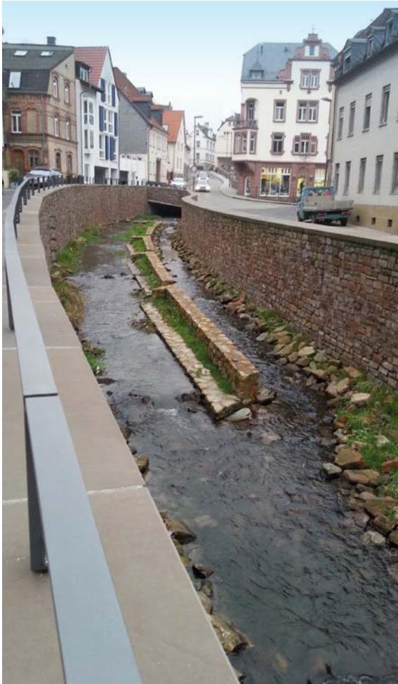
Abbildung 26: Hochwasserlenkungsmaßnahmen am Rambach in Wiesbaden-Sonnenberg
