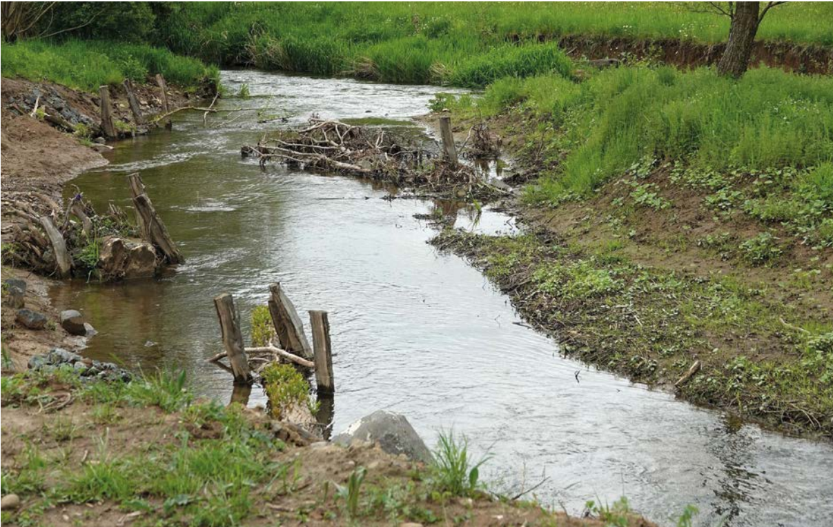
Abbildung 20: Beispielmaßnahme für eine naturnahe Gewässerentwicklung im Rahmen der Gewässerunterhaltung
