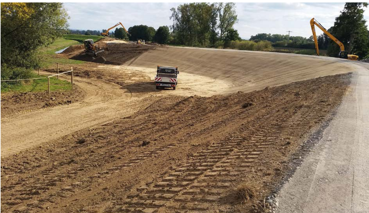
Abbildung 28: Deichsanierung am Beispiel des linken Weschnitzdeiches
