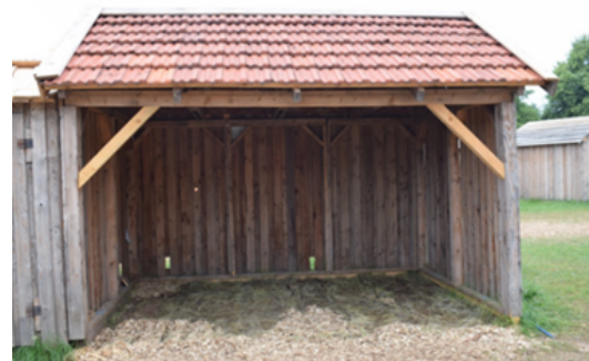
offene Hütte, kein Boden, Maße 3m tief, 4m breit
