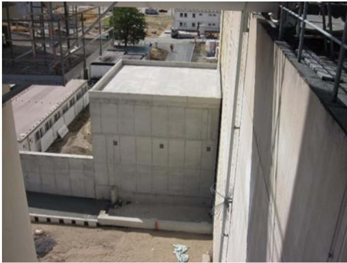
Abbildung: Anbau am HAG Block A zur optimierten Behandlung radioaktiver Abfälle
