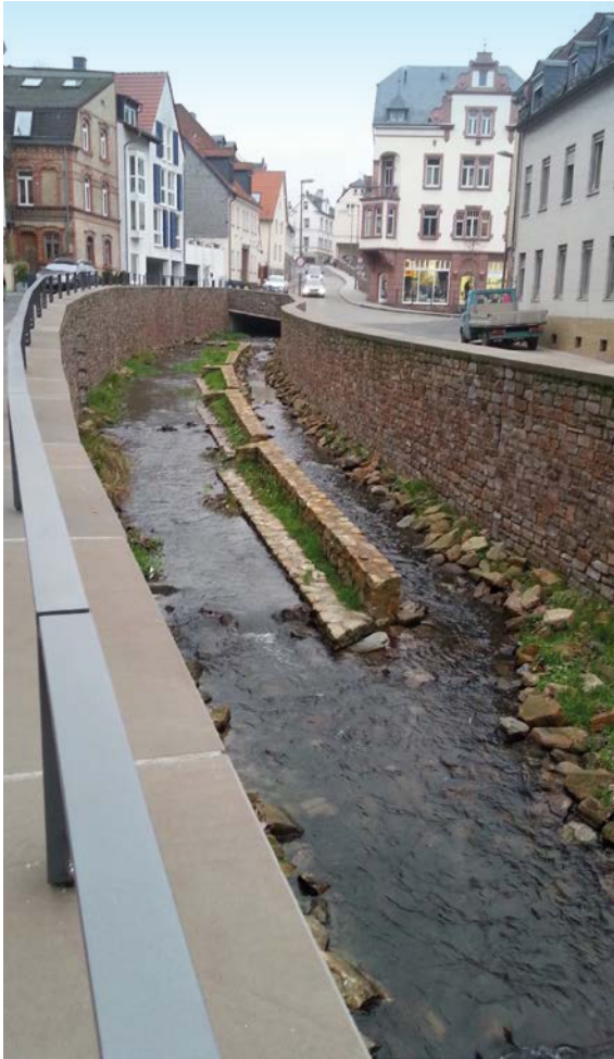
Abbildung 26: Hochwasserlenkungsmaßnahmen am Rambach in Wiesbaden-Sonnenberg
