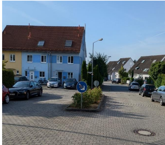
Pflanzung von zwei Straßenbäumen in der Adolf- Kolping-Straße
