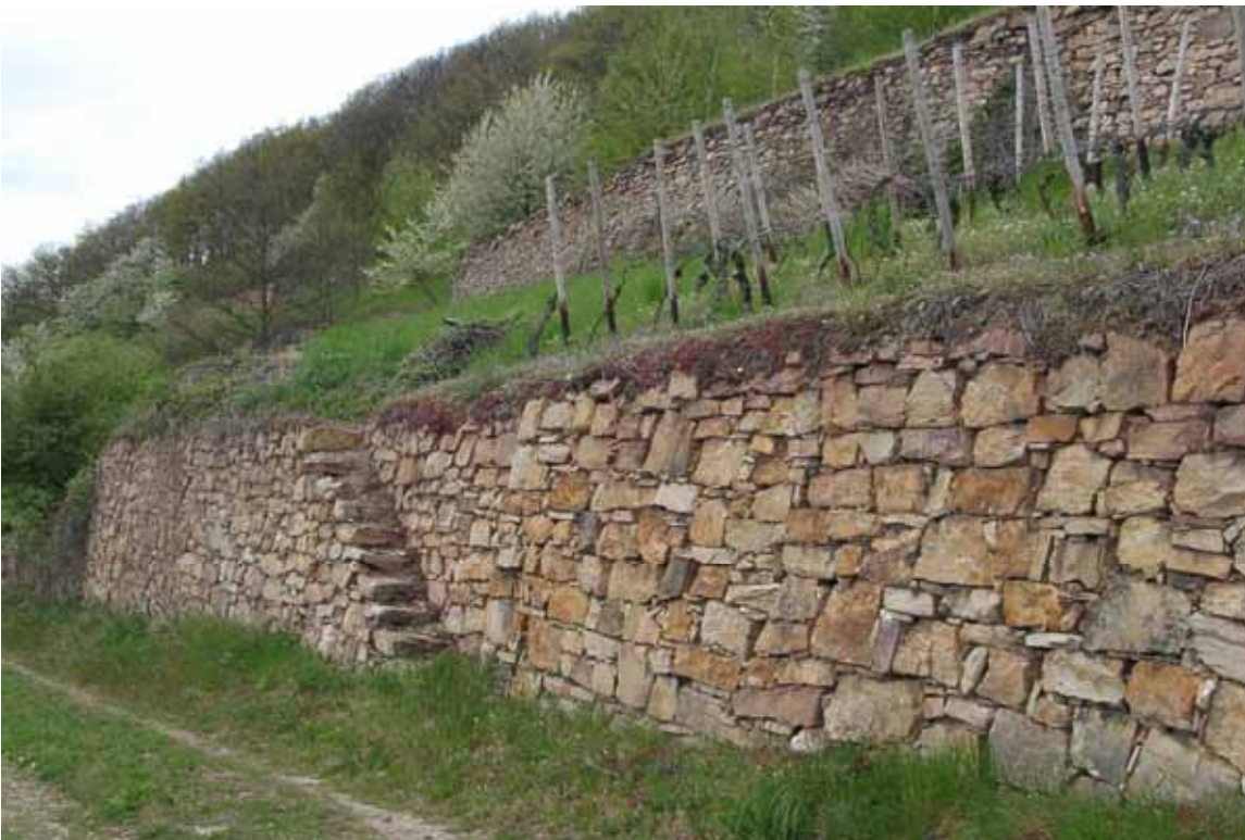
Wiederhergestellte Weinbergstrockenmauern in Rüdesheim
