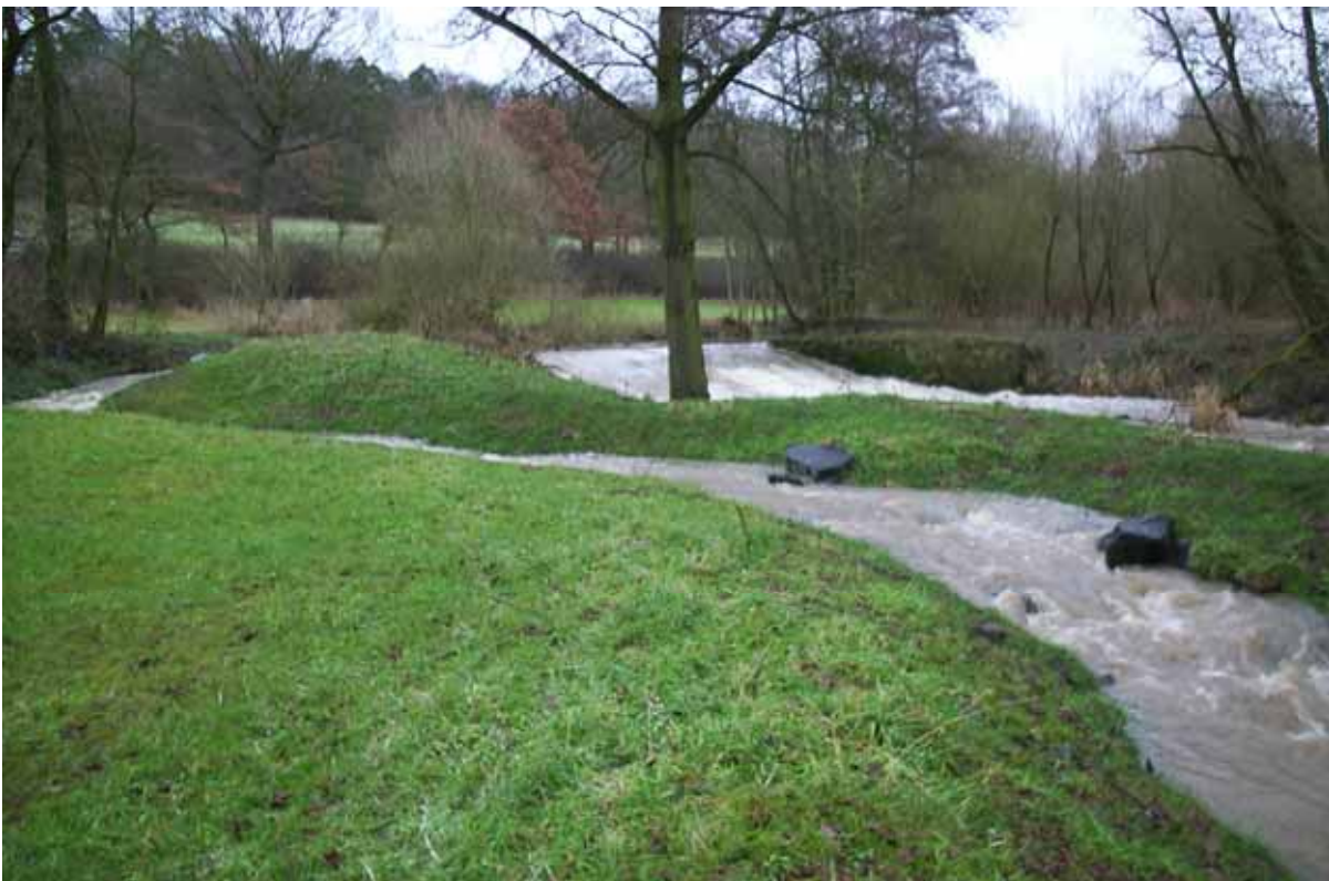
Fischaufstiegsanlage an der Gleen (hergestellt in der Flurneuordnung Kirtorf-Lehrbach) Foto: Flurbereinigungsbehörde Lauterbach
