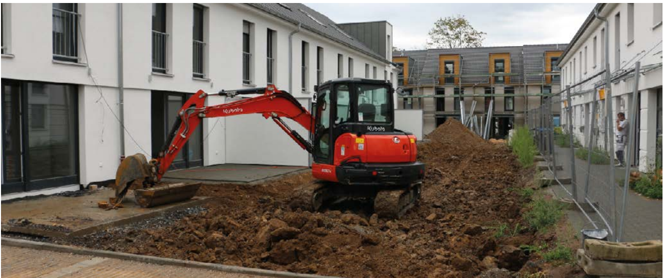
Bodenarbeiten zur Herstellung von Grünflächen in einem Neubaugebiet
