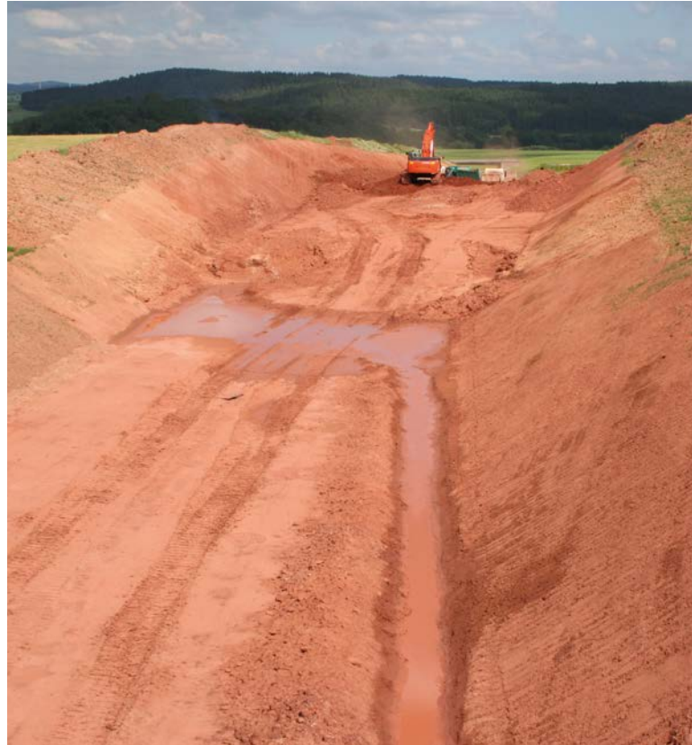
Straßenbau mit tiefen Bodeneingriffen
